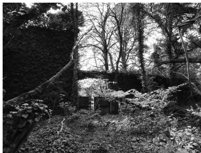
La ferme des Essarts dans son état actuel (cliché ARORY)
